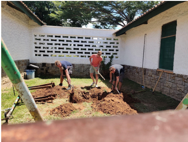
werkzaamheden voor zonneboilers (2022)
