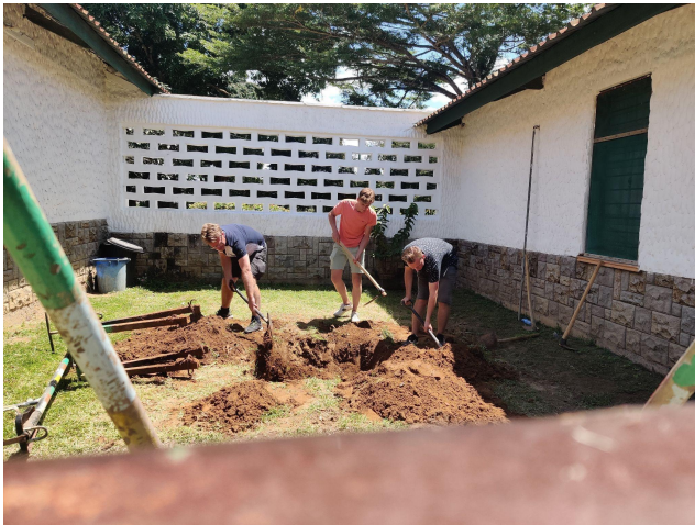
werkzaamheden voor zonneboilers (2022)
